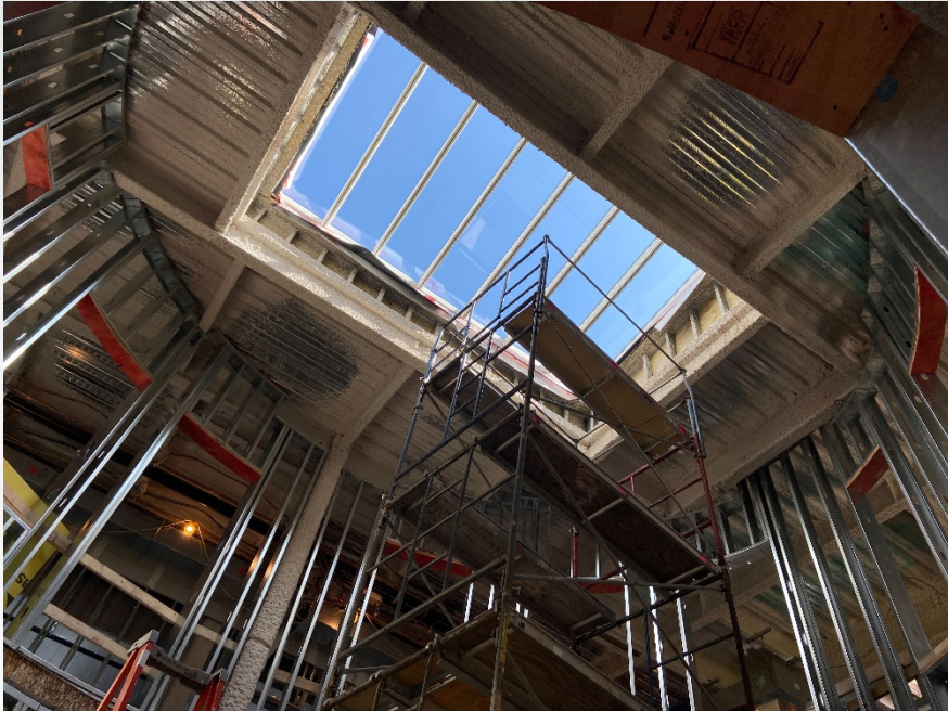
Bldg. B Skylight
