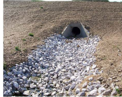
Riprap Outlet Protection
